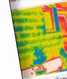
Bild 4: Erhöhte Temperaturen im Bereich Geschloßdecke und in den Mauerwerkstufen → Wärmebrücke infolge Fugenmörtel.
